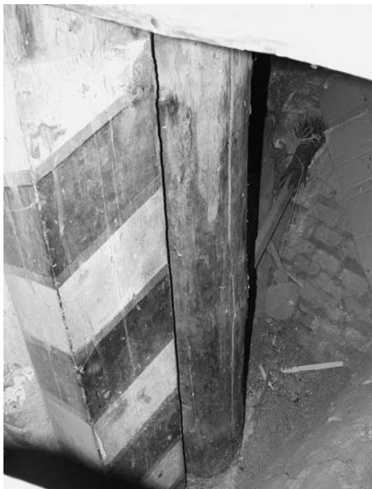
5 iliustracija. Apskrito skerspjūvio perdangos statramsčio prie užlipimo į pastogę, datuotas 1760 m. Adomo Vito nuotrauka, 2018
